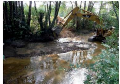
Mesure d'accompagnement de l'abaissement de la ligne d'eau : mise en place de « banquettes latérales »
